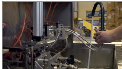
Testování tlakovou vodou
